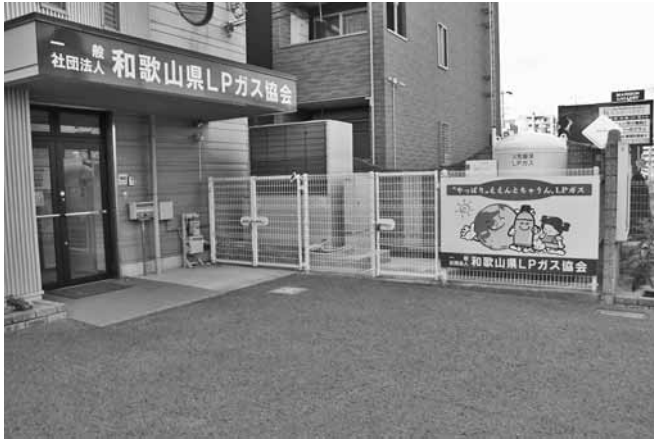
新しくなったGHP&縦型バルク貯槽
